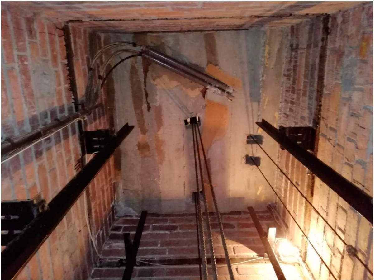
Рисунок 3 – Плита перекрытия шахты
