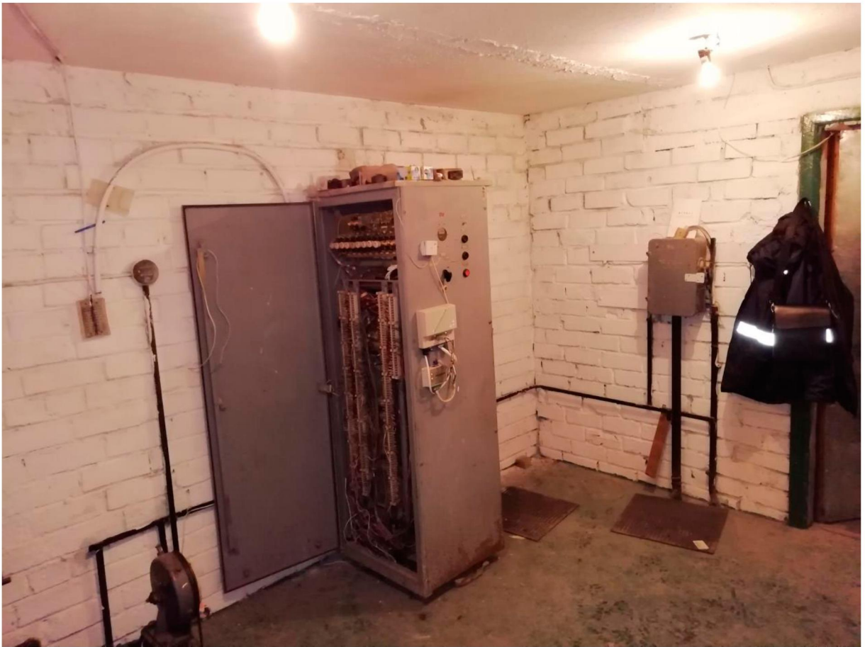
Рисунок 5 – Шкаф управления
