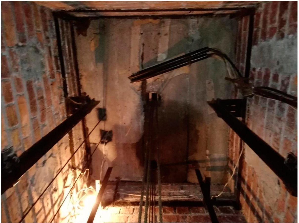
Рисунок 3 – Плита перекрытия шахты
