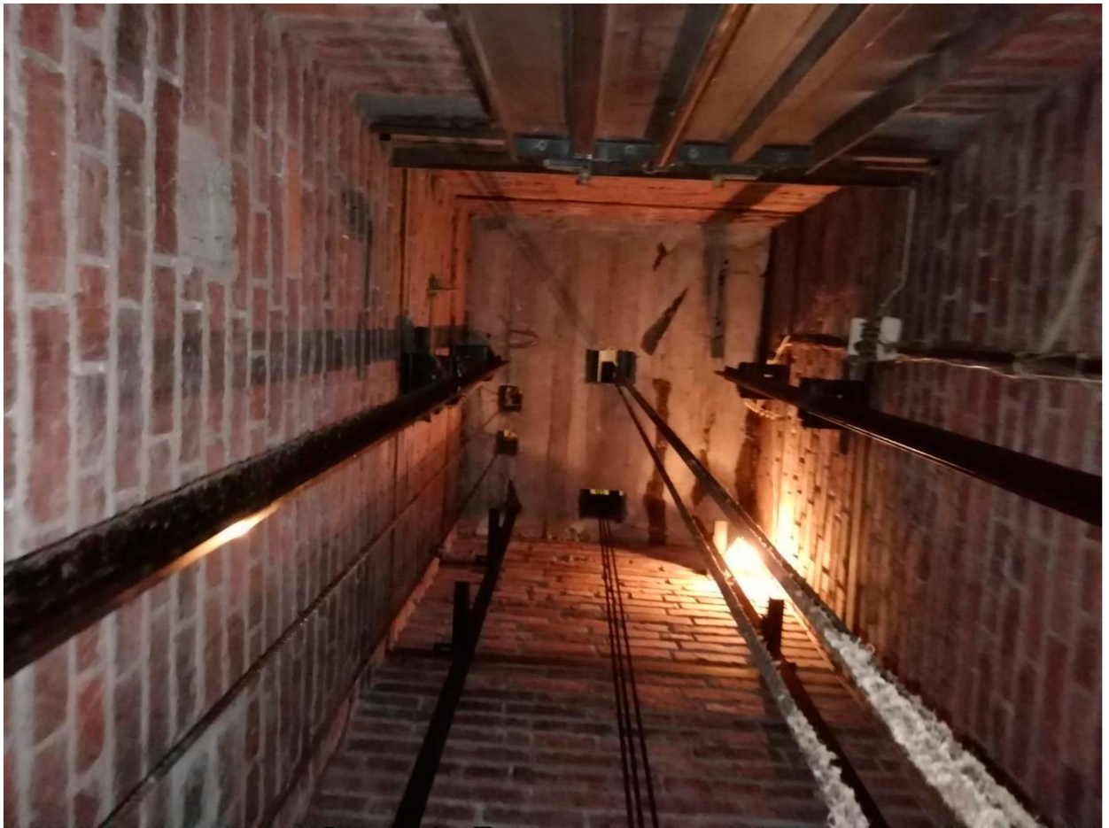
Рисунок 3 – Плита перекрытия шахты
