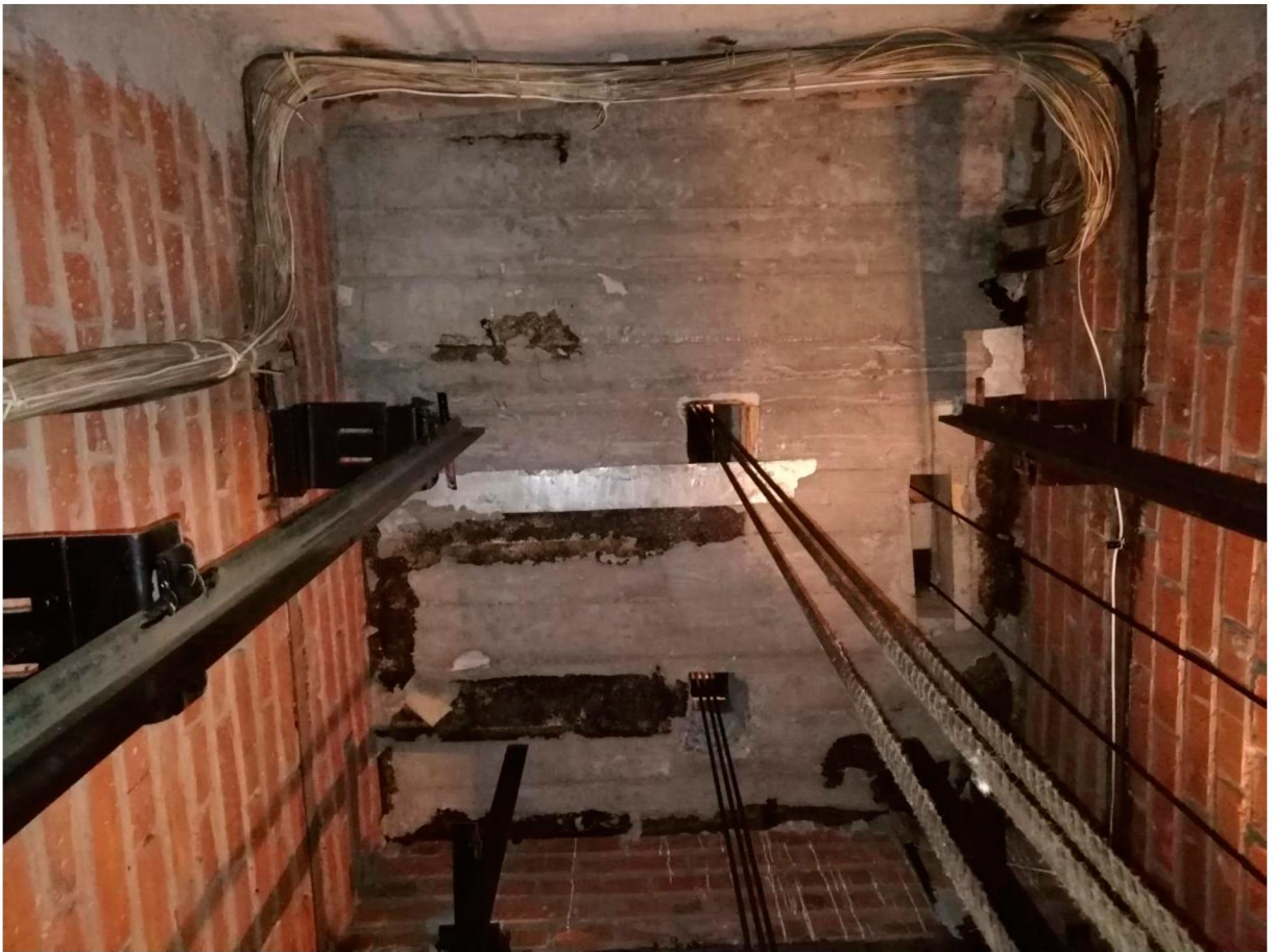
Рисунок 3 – Плита перекрытия шахты
