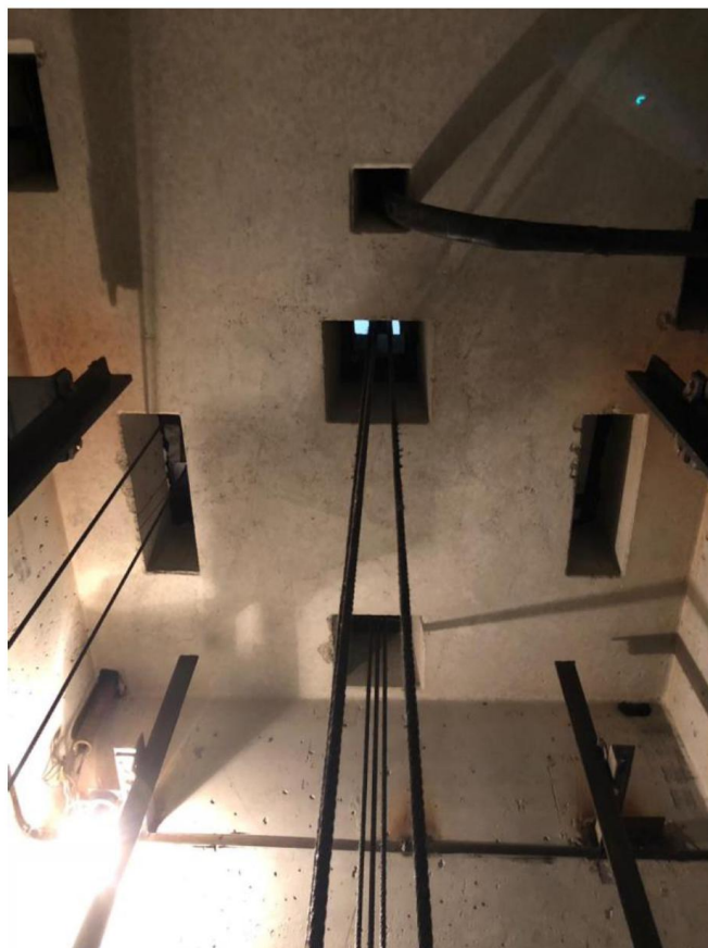
Рисунок 3 – Плита перекрытия шахты
