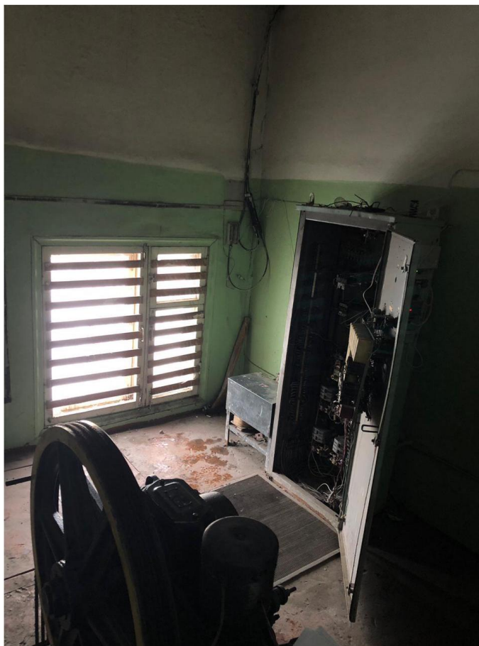
Рисунок 5– Шкаф управления
