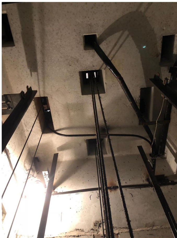
Рисунок 4 – Плита перекрытия шахты
