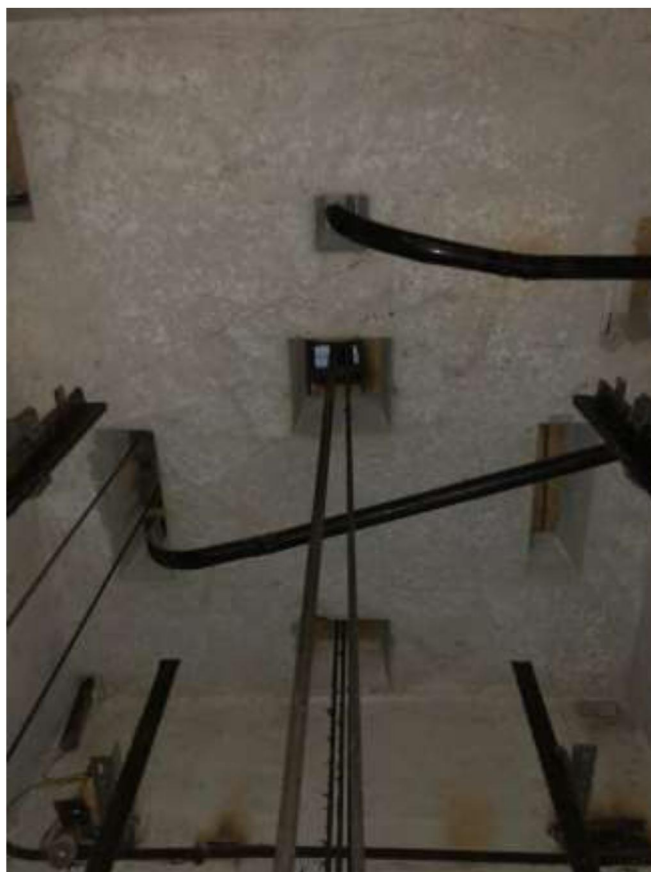
Рисунок 3 – Плита перекрытия шахты
