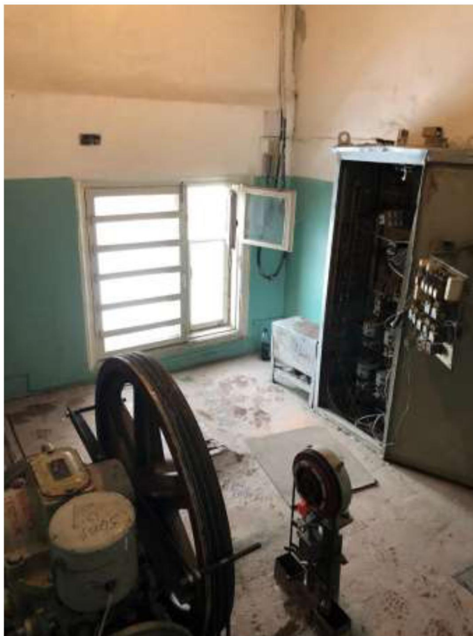
Рисунок 5– Шкаф управления
