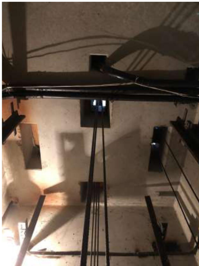
Рисунок 3 – Плита перекрытия шахты
