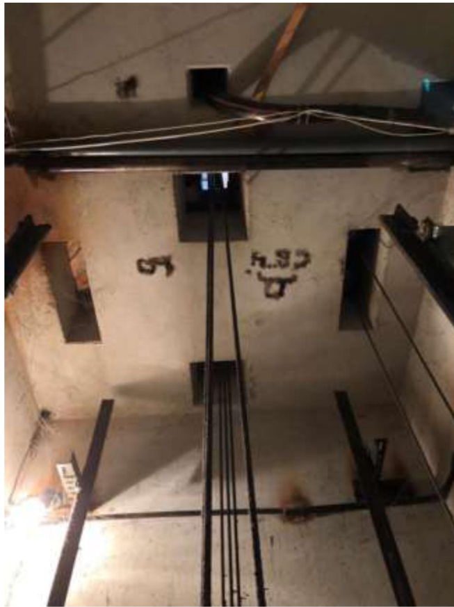
Рисунок 3 – Плита перекрытия шахты
