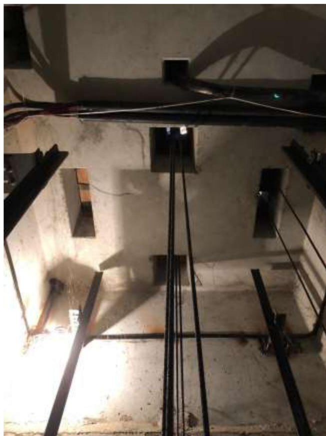
Рисунок 3 – Плита перекрытия шахты
