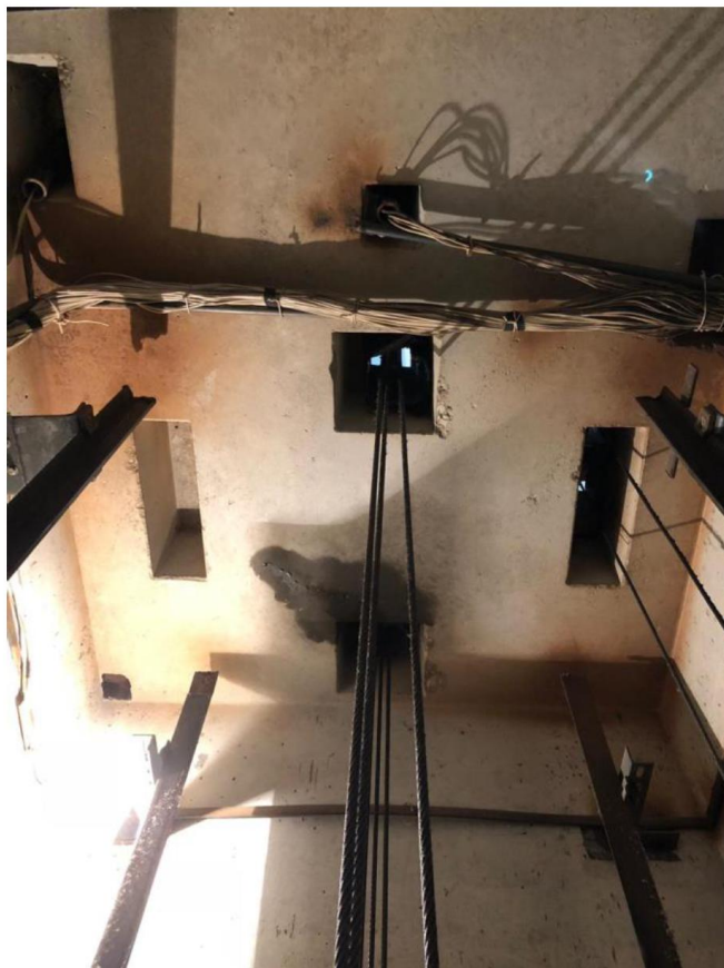
Рисунок 3 – Плита перекрытия шахты
