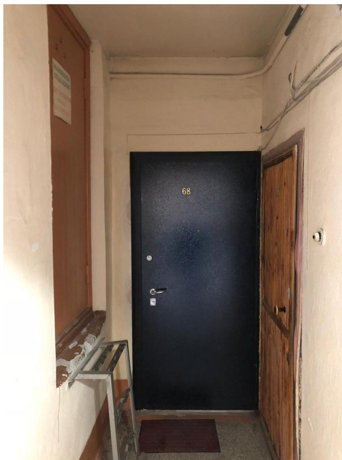
Рисунок 4 – Вход в машинное помещение
