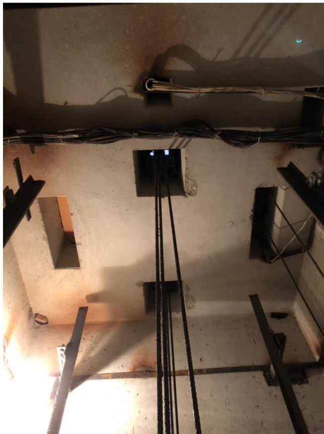
Рисунок 3 – Плита перекрытия шахты
