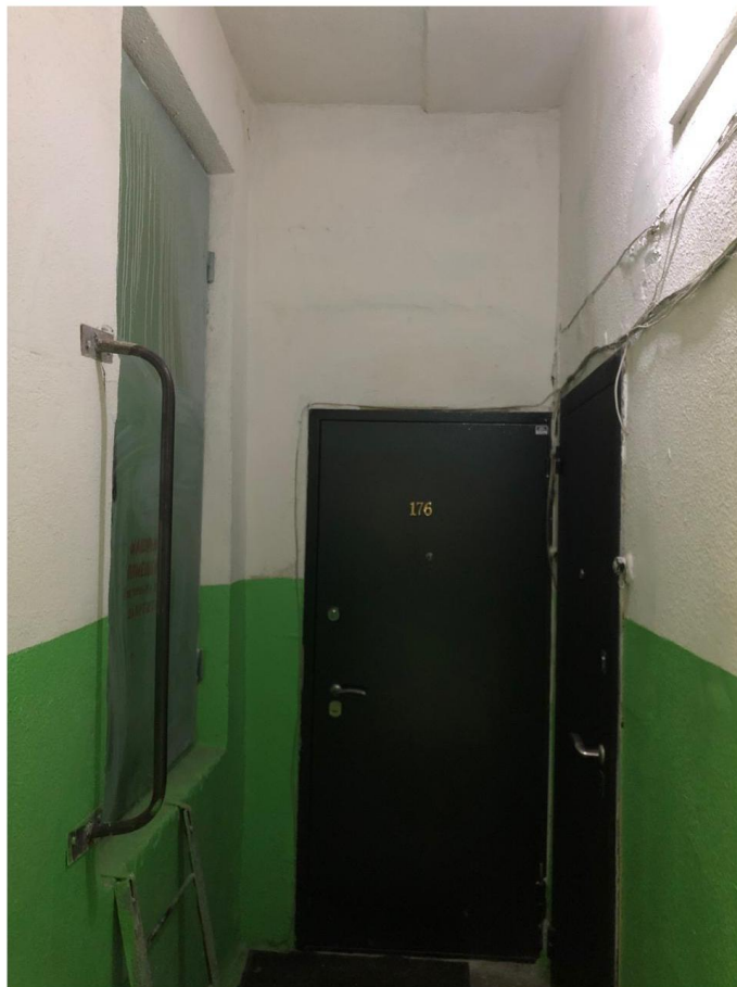
Рисунок 4 – Вход в машинное помещение
