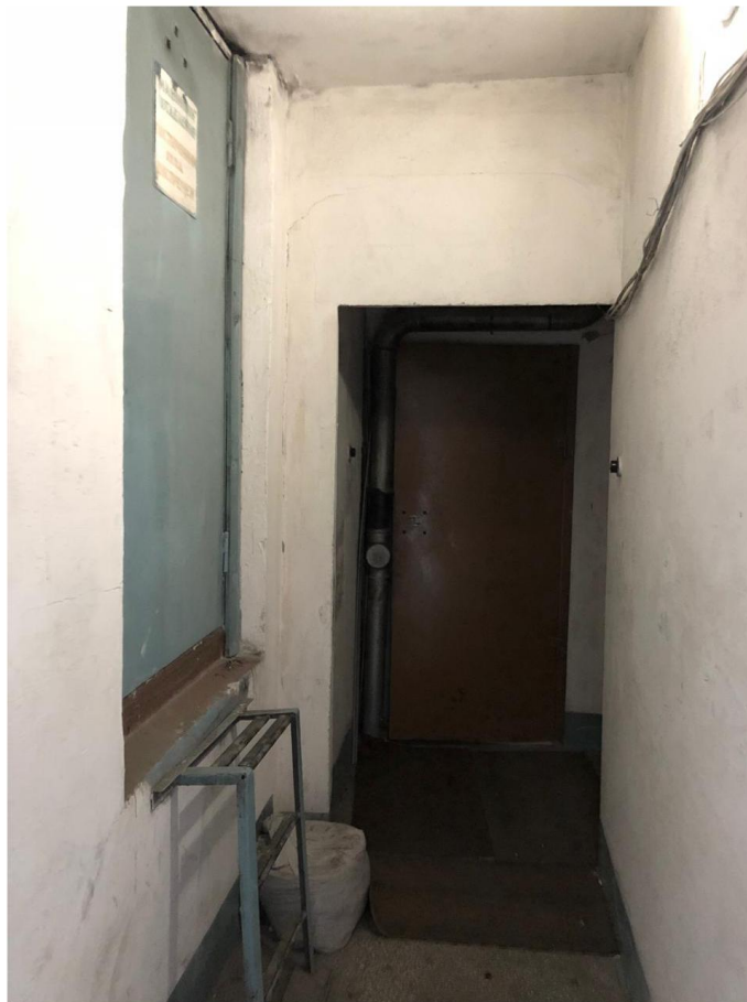
Рисунок 4 – Вход в машинное помещение
