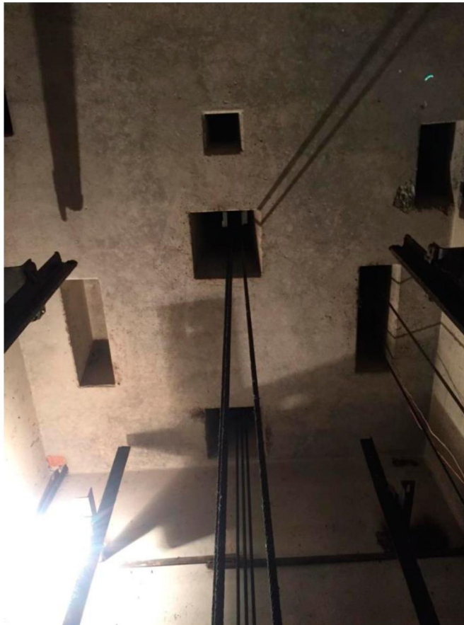
Рисунок 3 – Плита перекрытия шахты
