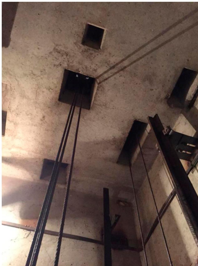
Рисунок 3 – Плита перекрытия шахты
