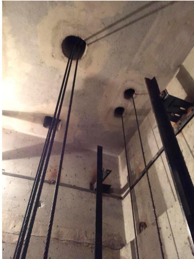
Рисунок 3 – Плита перекрытия шахты
