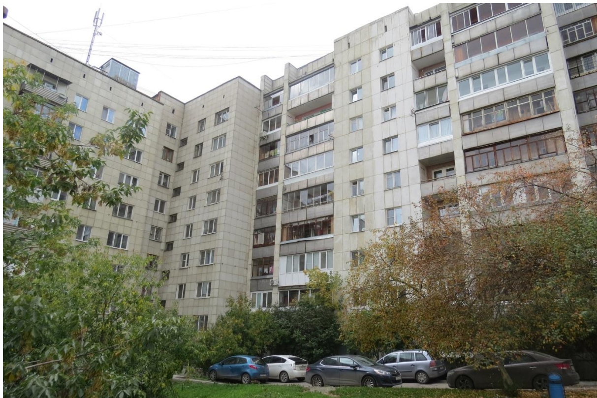
Фото Б1. Общий вид здания жилого дома
