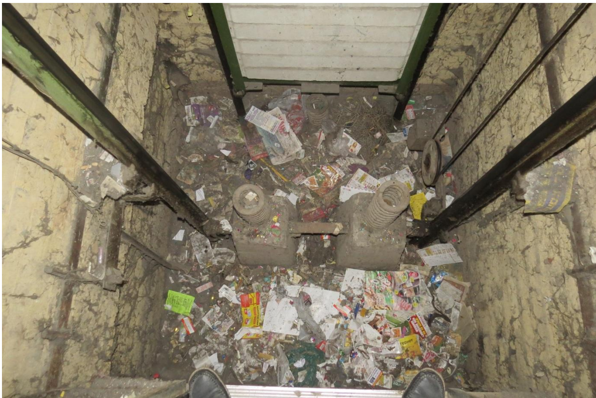
Фото Б5. Вид на приямок лифтовой шахты
