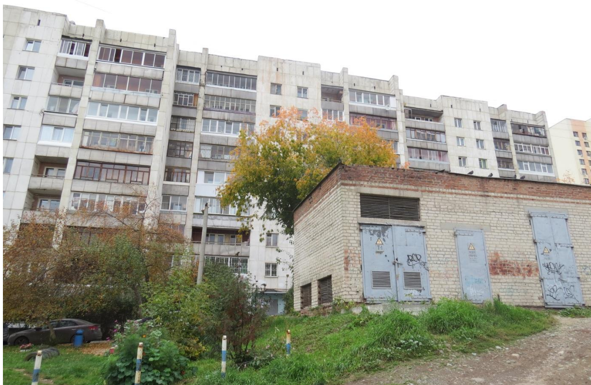
Фото Б2. Общий вид здания жилого дома
