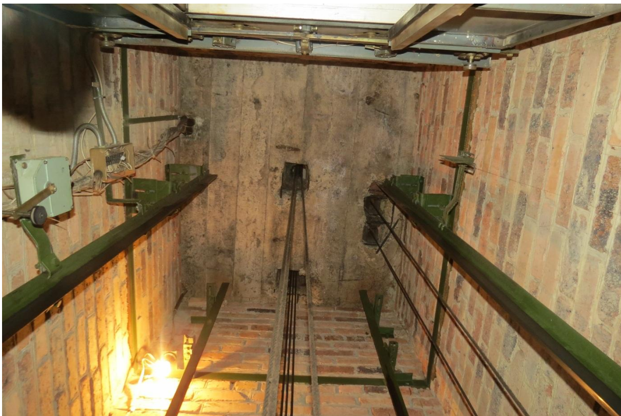
Фото Б4. Вид на плиту перекрытия лифтовой шахты
