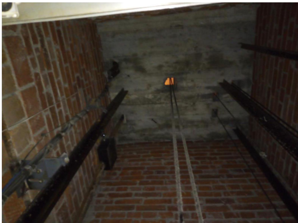
Рисунок 3 – Плита перекрытия шахты
