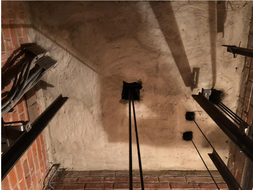
Рисунок 3 – Плита перекрытия шахты
