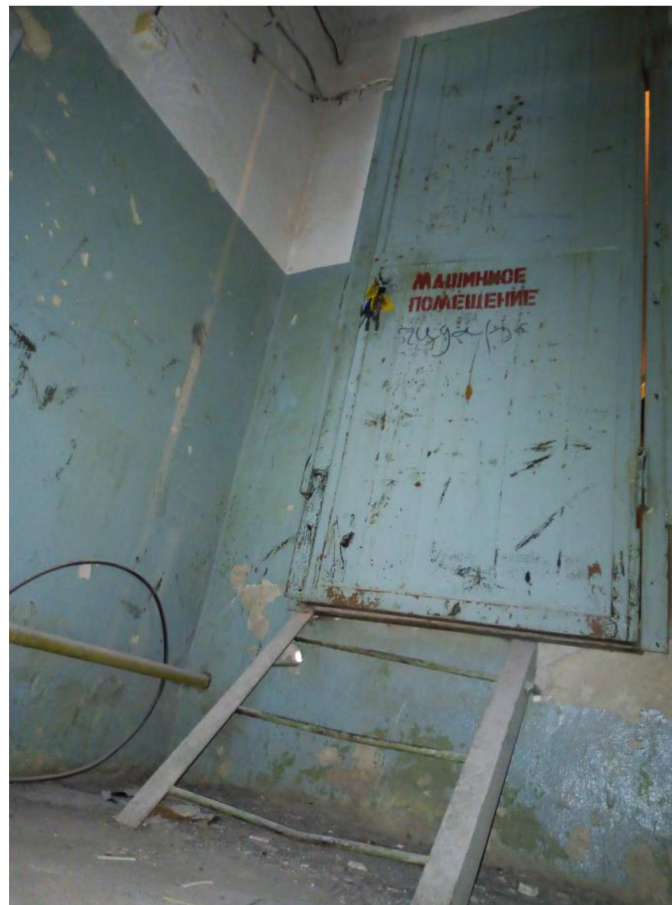
Рисунок 4– Вход в машинное помещение
