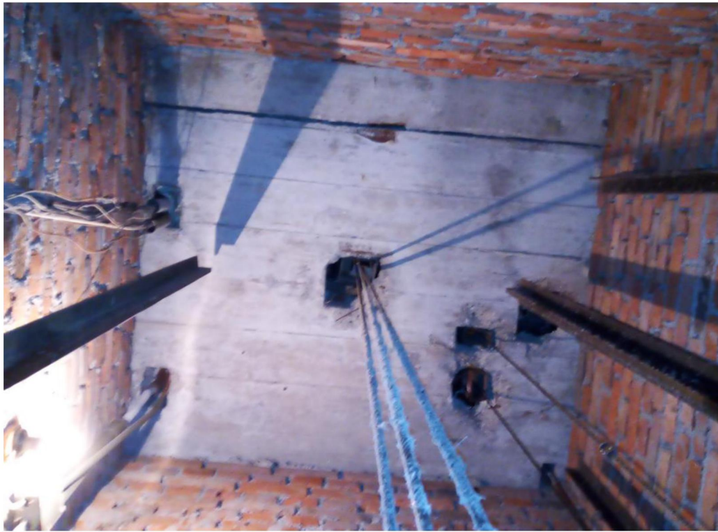
Рисунок 3 – Плита перекрытия шахты
