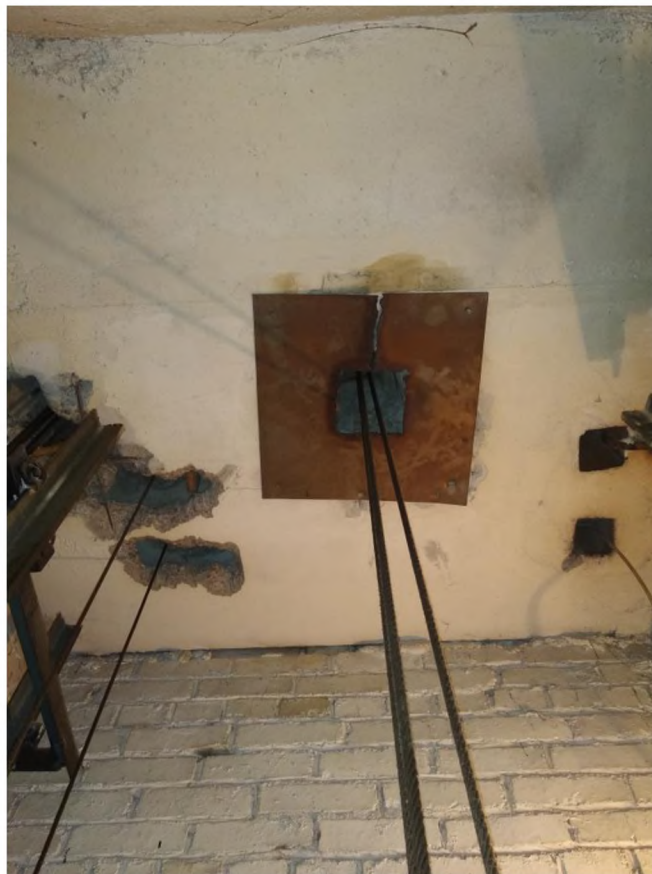
Рисунок 3 – Плита перекрытия шахты
