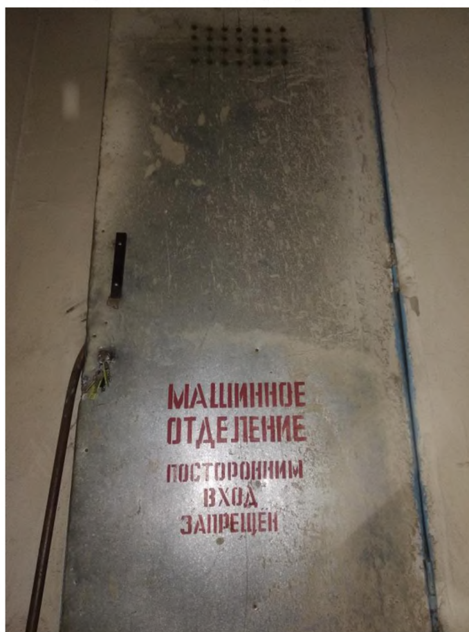
Рисунок 4 – Вход в машинное помещение
