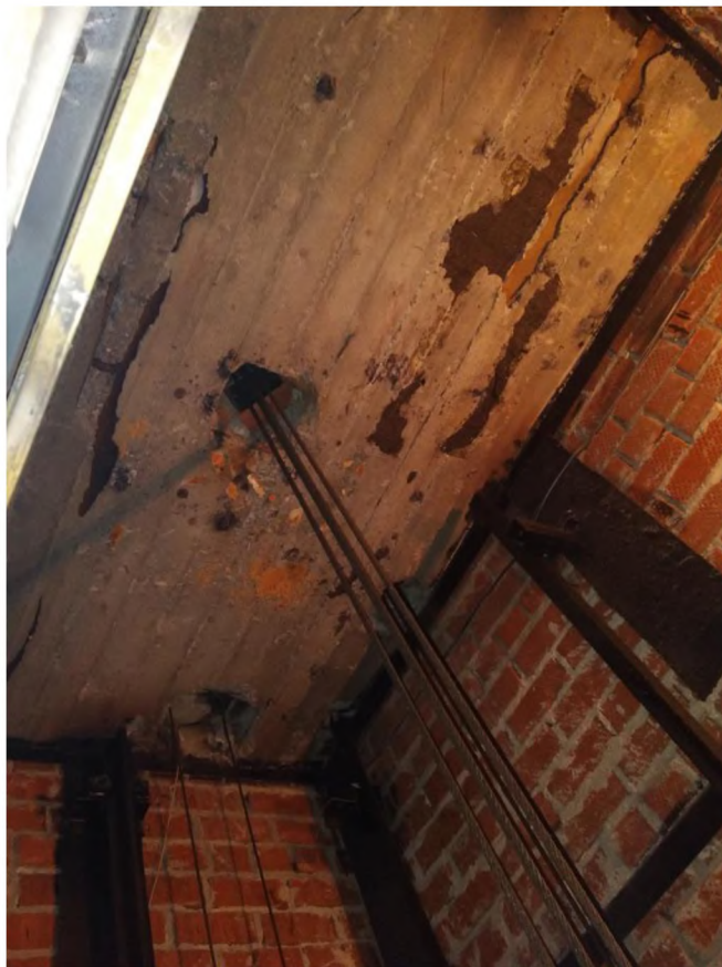
Рисунок 3 – Плита перекрытия шахты
