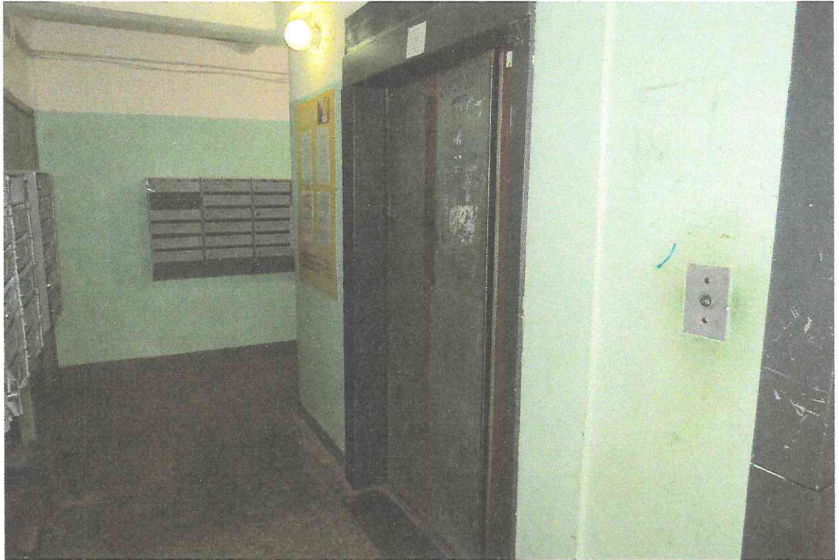
Фото А3. Вид на дверной проем лифтовой шахты грузопассажирского лифта
