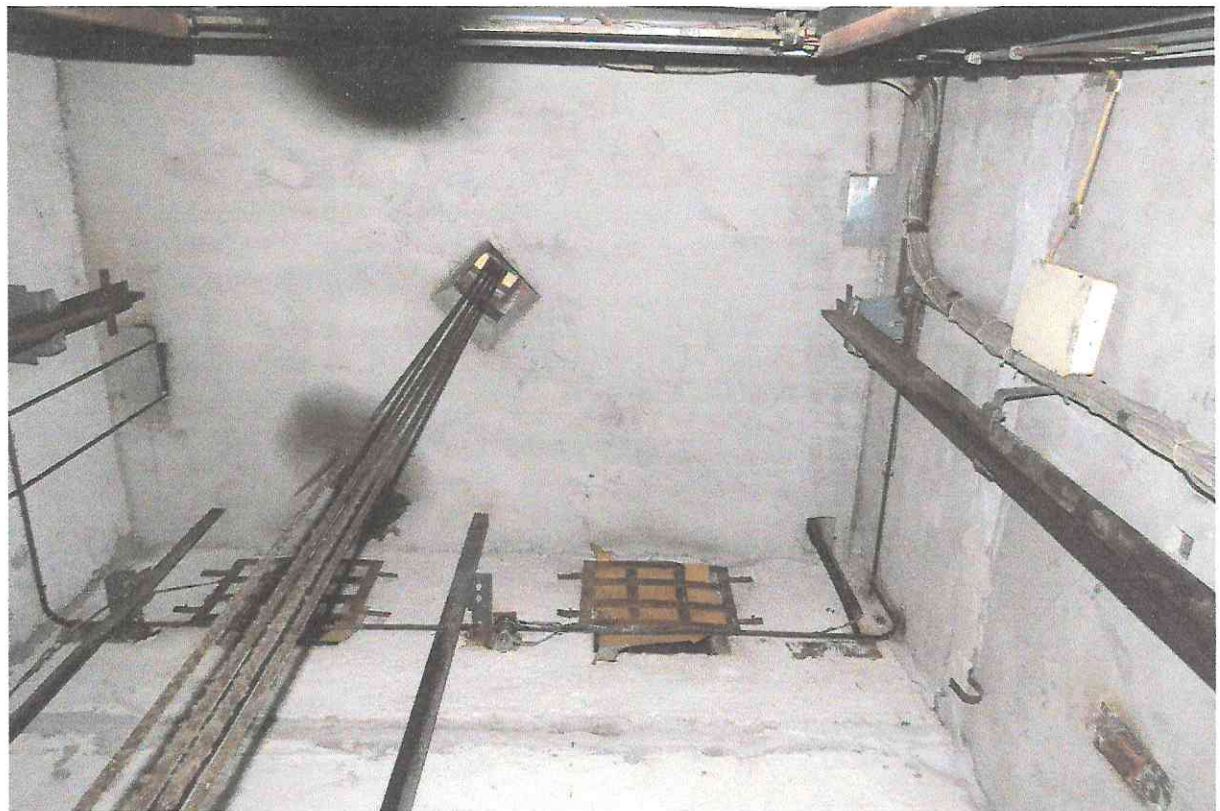
Фото А4. Вид на плиту перекрытия лифтовой шахты грузопассажирского лифта
