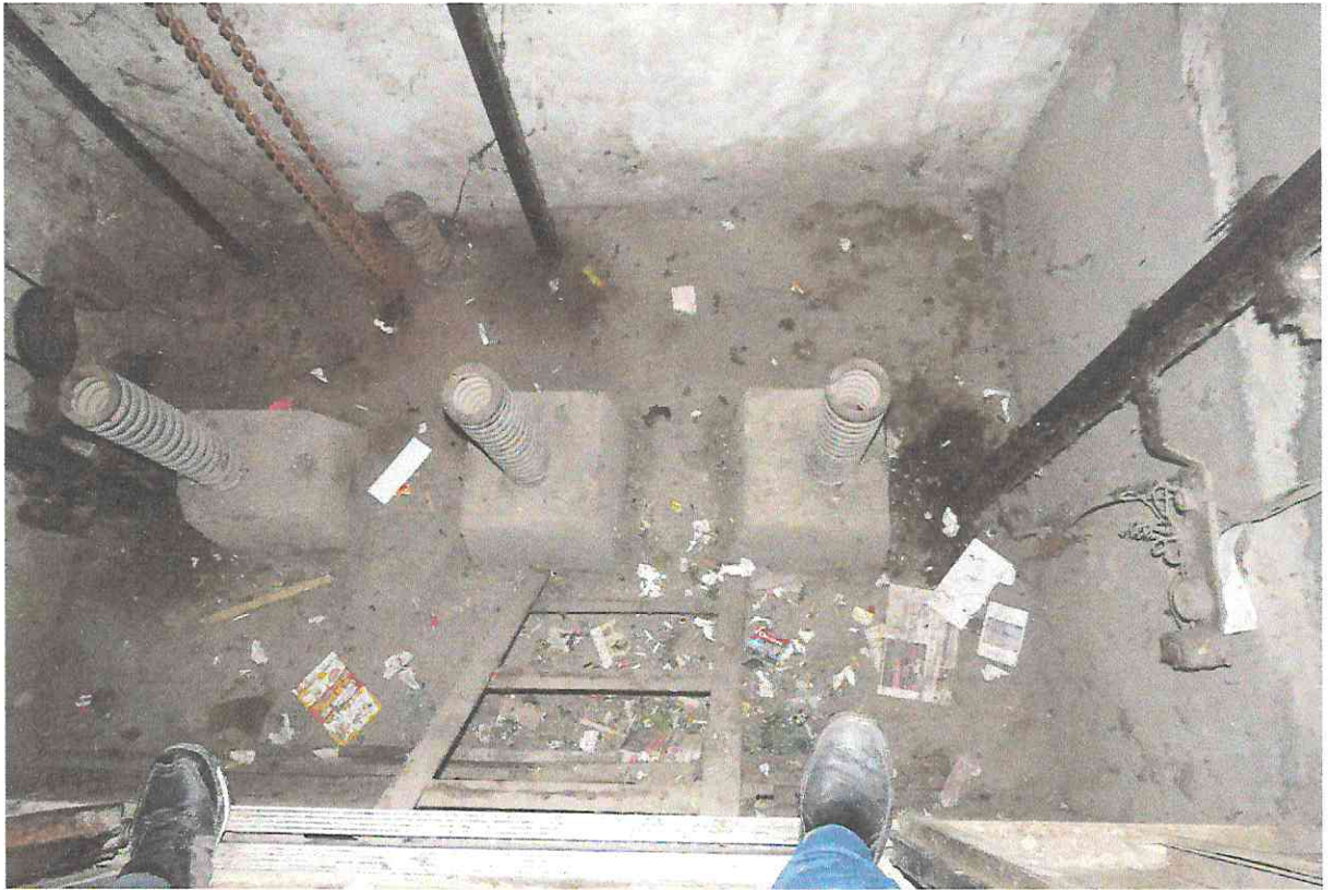
Фото А5. Вид на прямок лифтовой шахты грузопассажирского лифта
