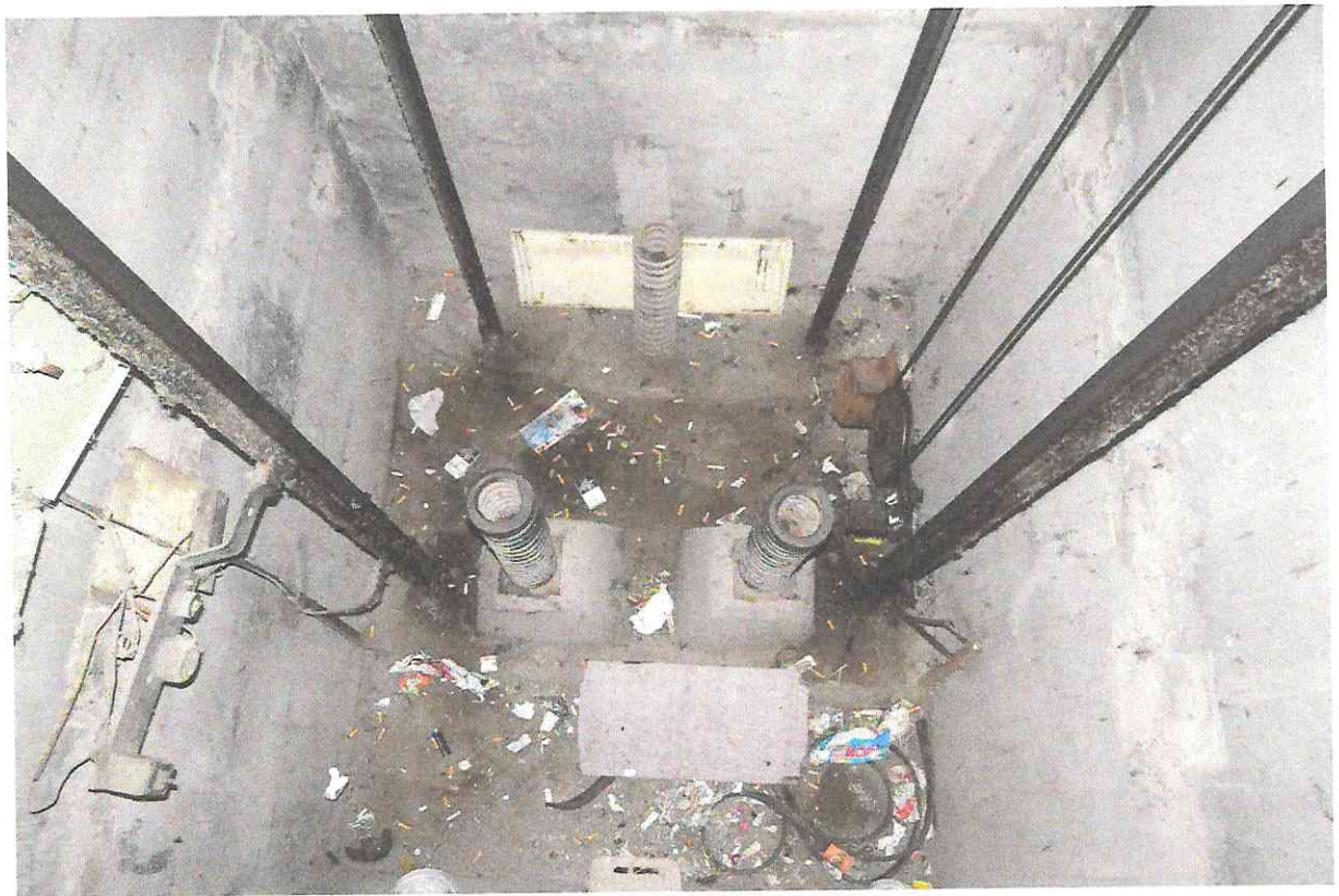
Фото А8. Вид на прямок лифтовой шахты пассажирского лифта
