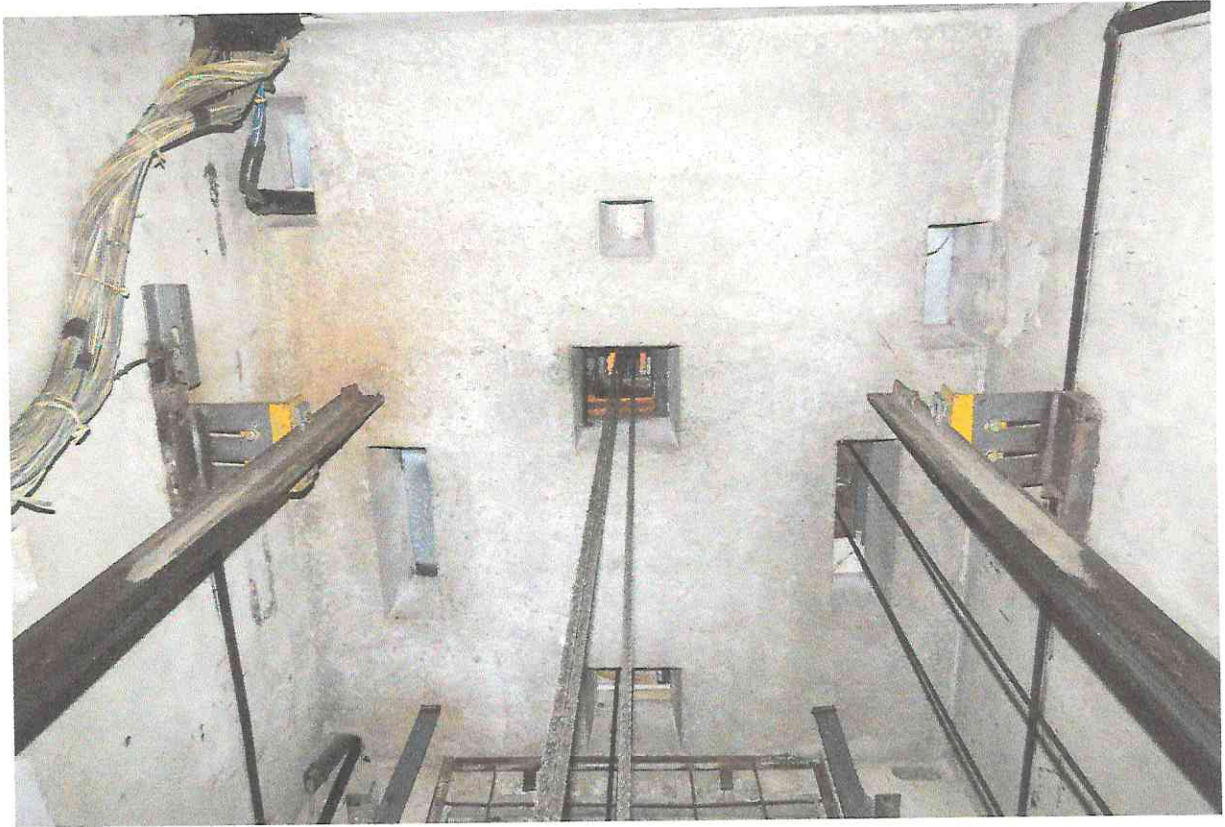
Фото А7. Вид на плиту перекрытия лифтовой шахты пассажирского лифта
