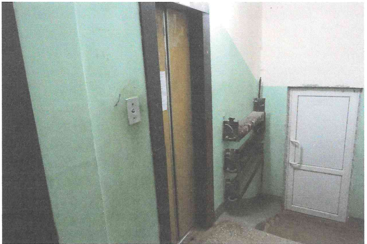
Фото А6. Вид на дверной проем лифтовой шахты пассажирского лифта
