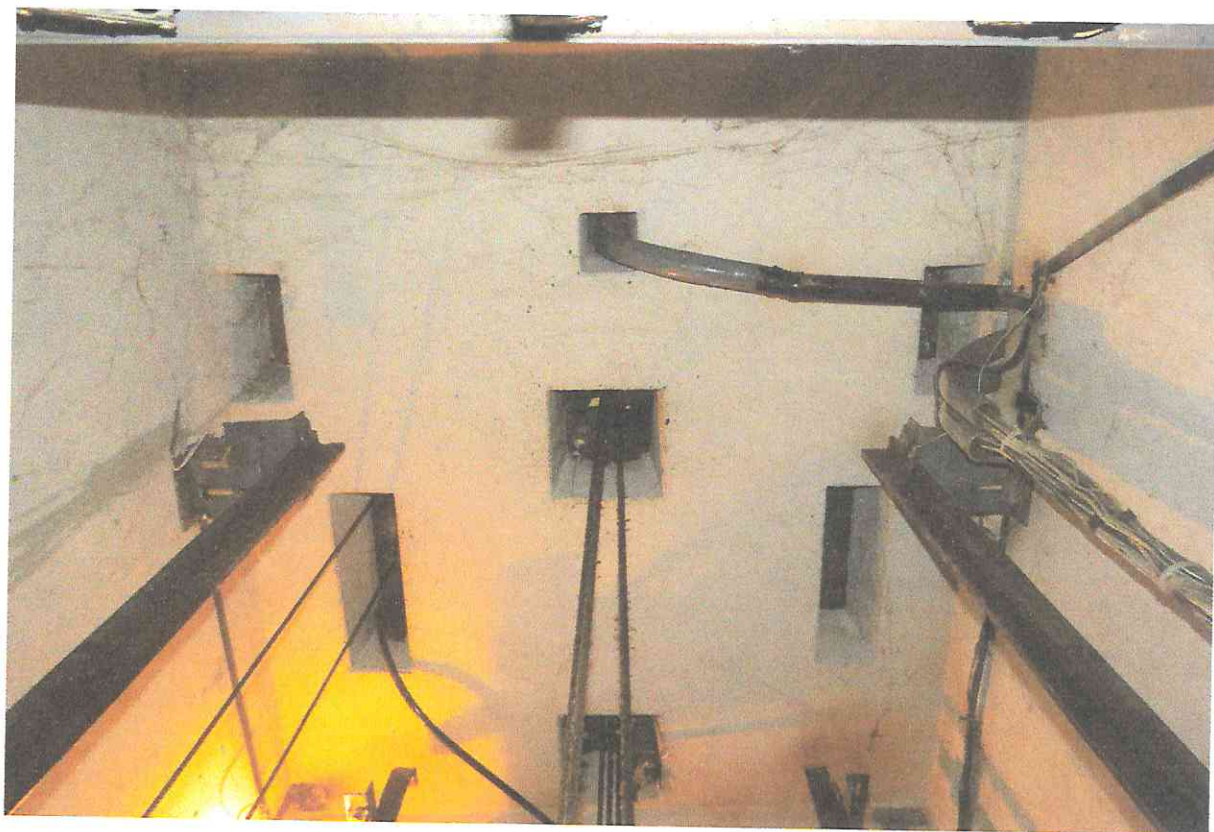
Фото А5. Вид на плиту перекрытия лифтовой шахты 1 подъезда
