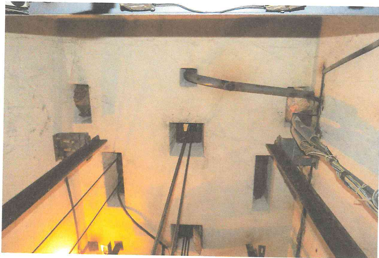
Фото А9. Вид на плиту перекрытия лифтовой шахты 2 подъезда
