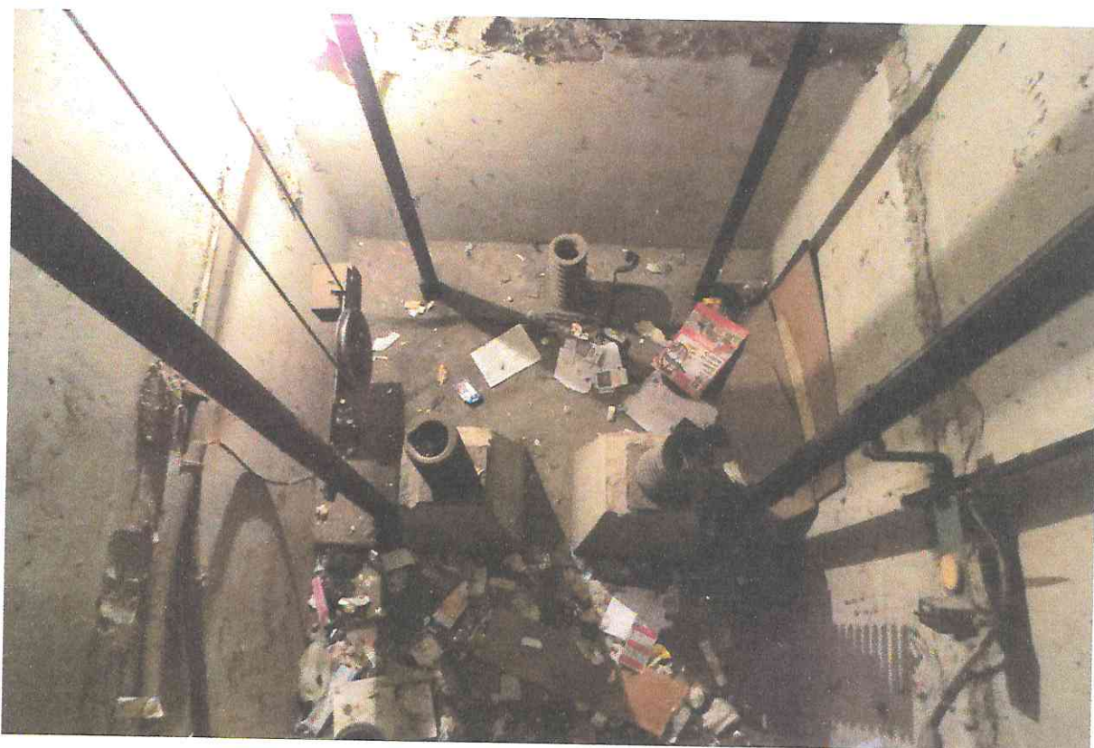
Фото А6. Вид на приямок лифтовой шахты 1 подъезда
