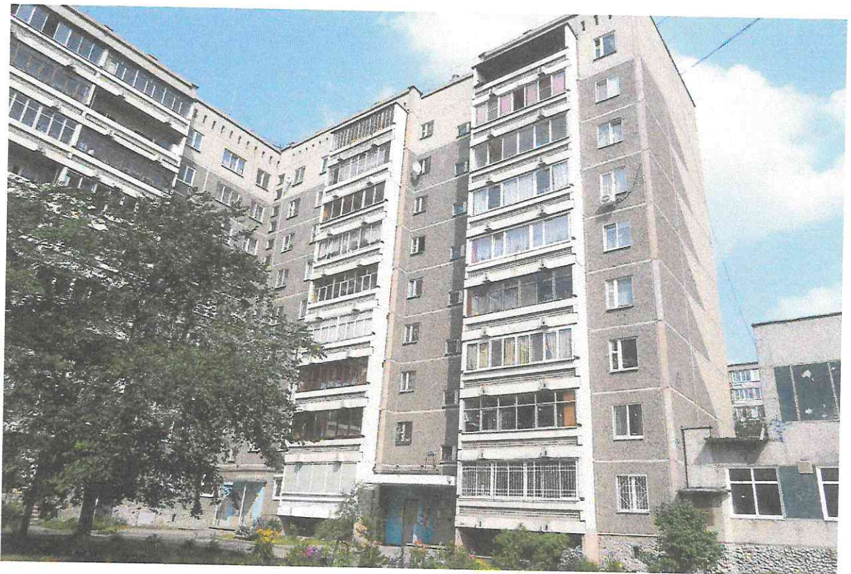
Фото А2. Общий вид здания
