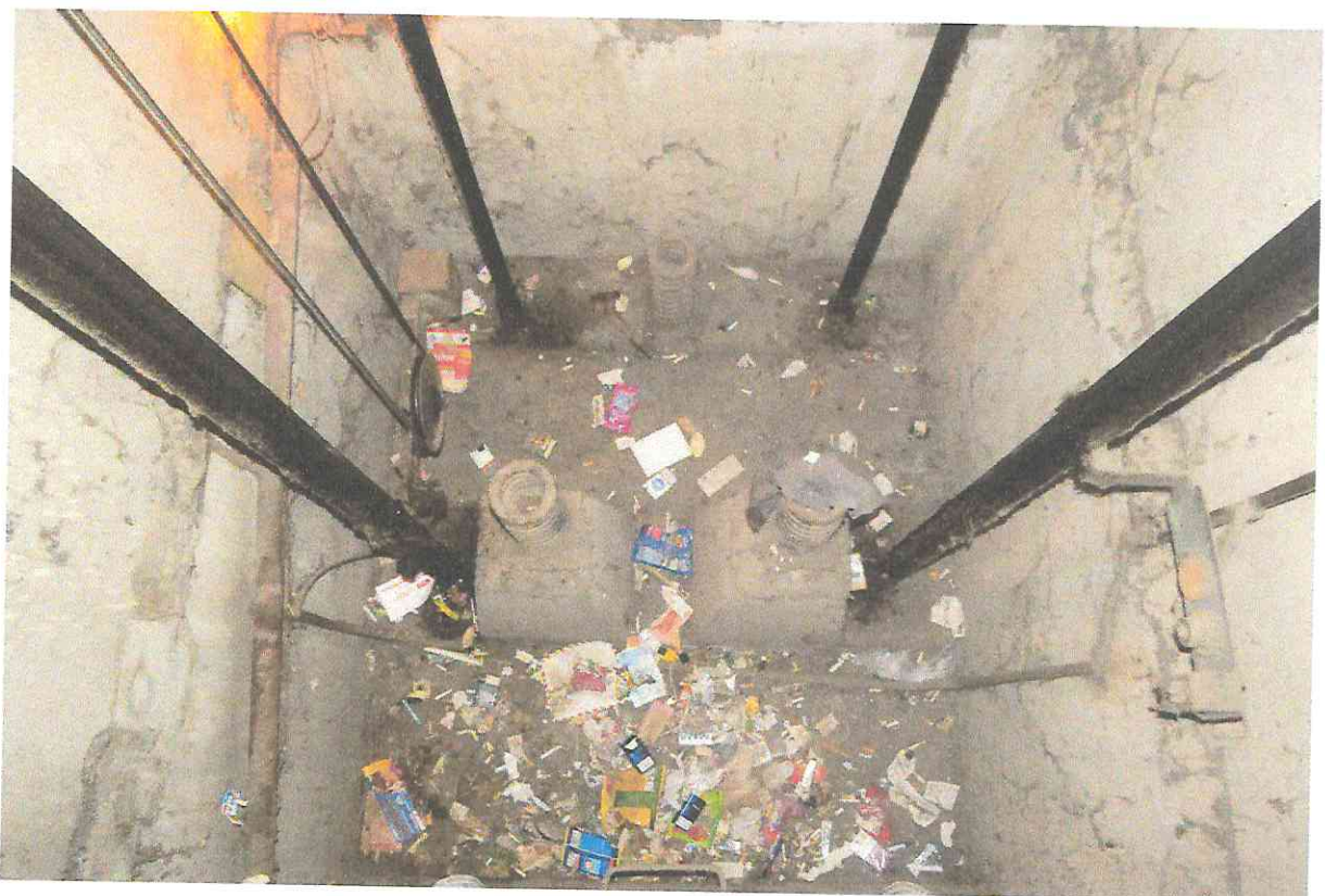
Фото А14. Вид на приямок лифтовой шахты 3 подъезда
