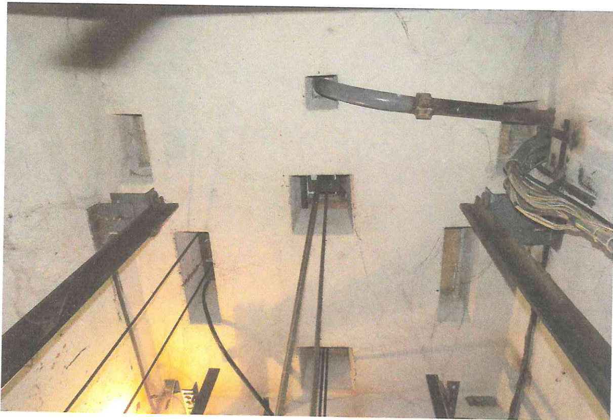
Фото А17. Вид на плиту перекрытия лифтовой шахты 4 подъезда
