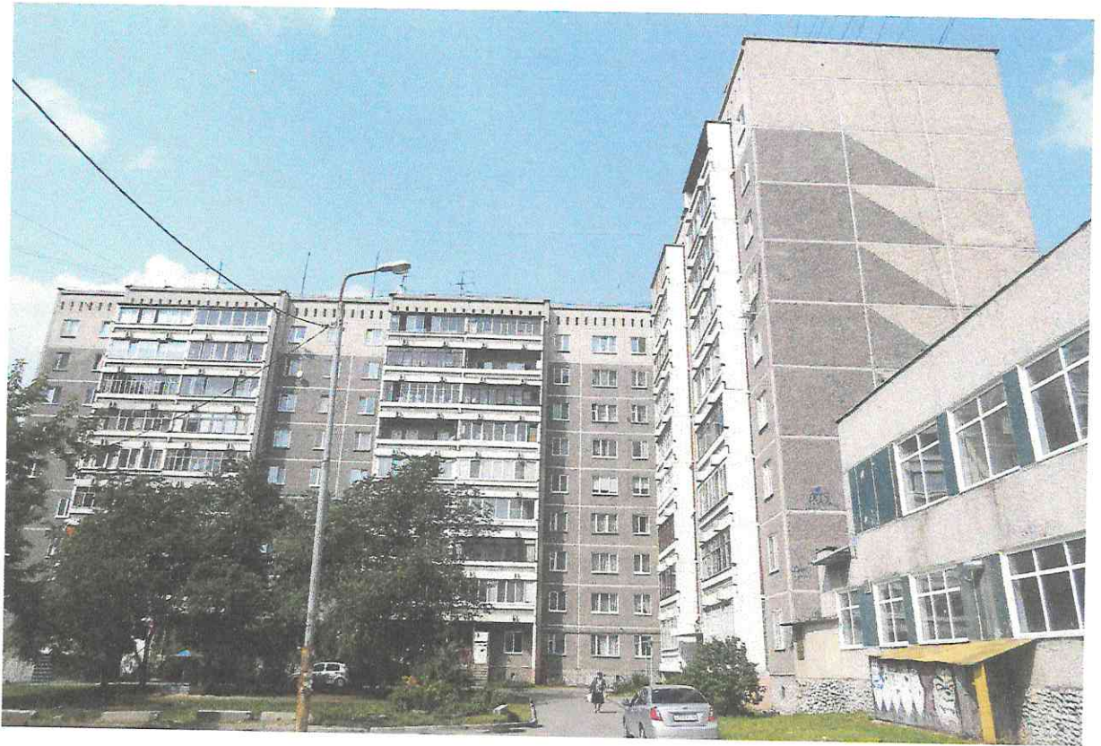
Фото А1. Общий вид здания
