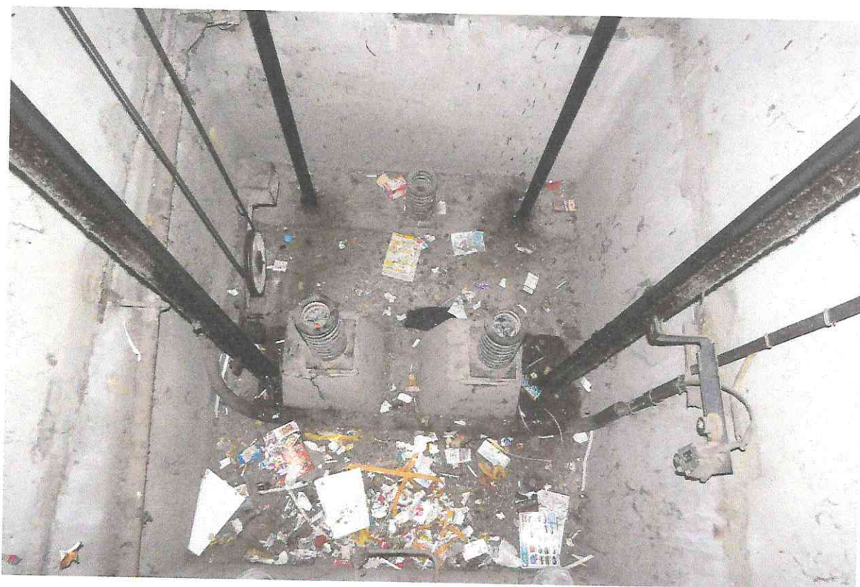
Фото А10. Вид на приямок лифтовой шахты 2 подъезда
