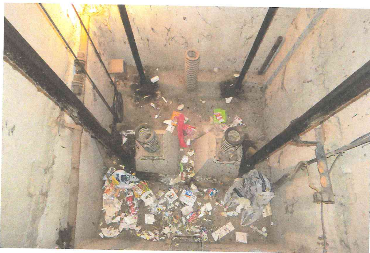
Фото А18. Вид на приямок лифтовой шахты 4 подъезда
