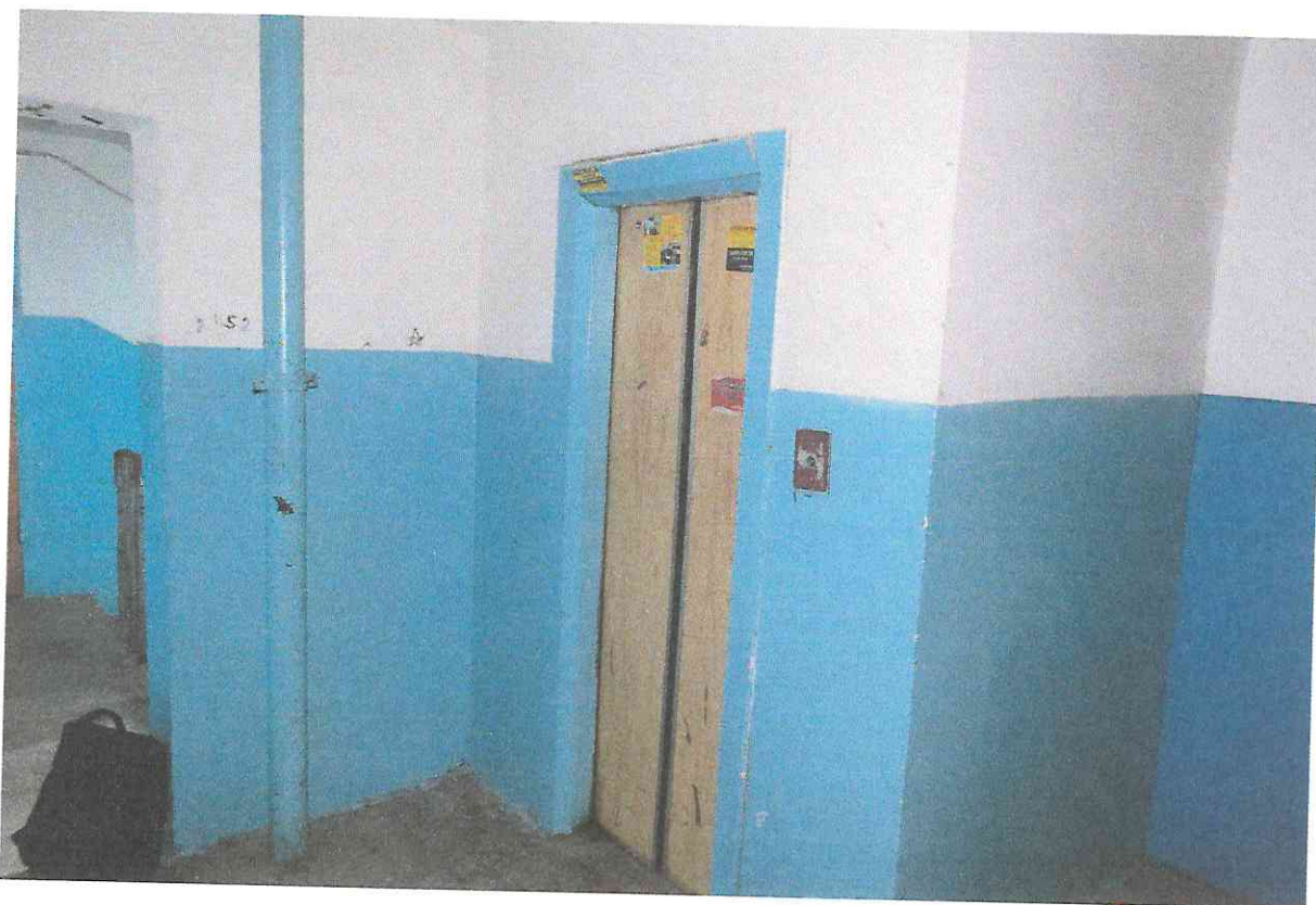
Фото А8. Вид на дверной проем лифтовой шахты 2 подъезда
