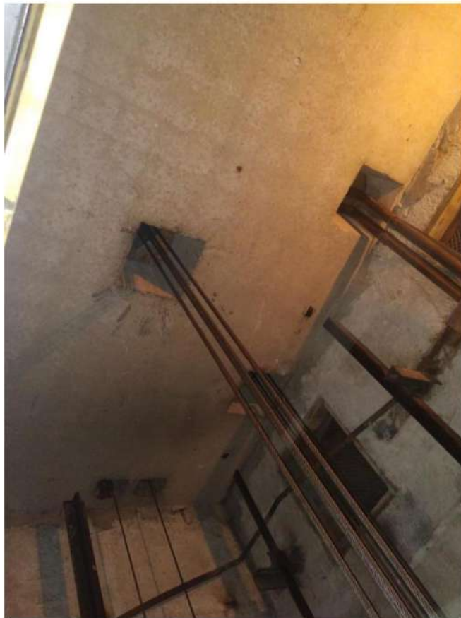
Рисунок 3 – Плита перекрытия шахты
