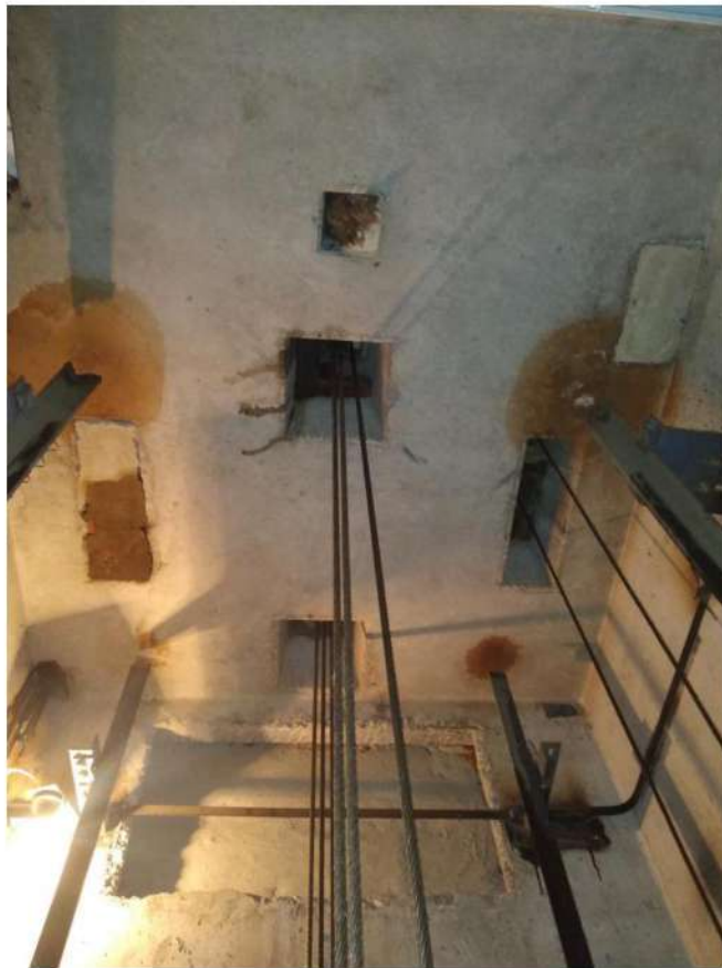
Рисунок 3 – Плита перекрытия шахты
