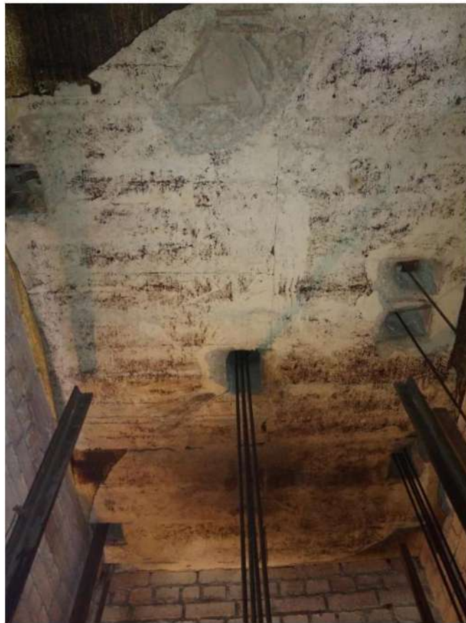
Рисунок 3 – Плита перекрытия шахты
