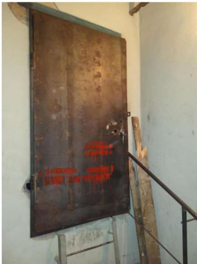
Рисунок 4 – Вход в машинное помещение
