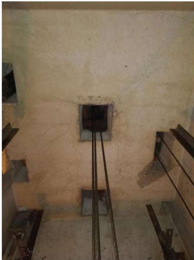
Рисунок 3 – Плита перекрытия шахты
