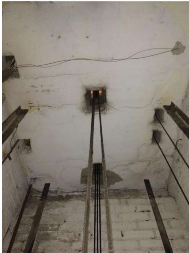
Рисунок 3 – Плита перекрытия шахты
